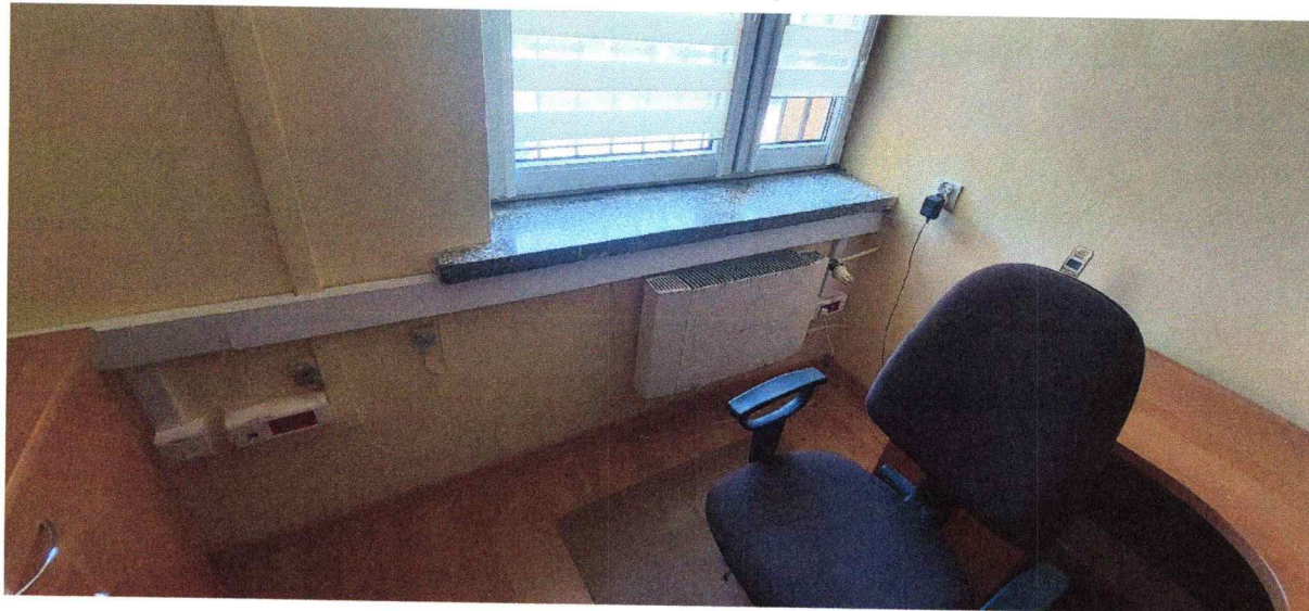
Fot.9. Widok okna, parapetu z konglomeratu do wymiany oraz grzejników w pokoju nr 7.
